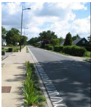
Exemple de requalification possible (CAUE 44)
