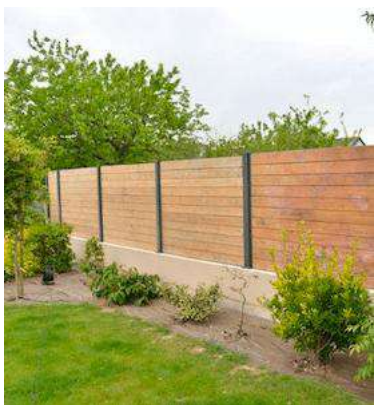
Clôture en fond de parcelle non adaptée au passage de la petite faune – à fortement limiter ou à adapter avec des passages
