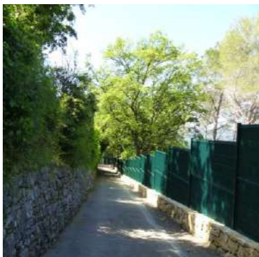
Panneaux rigides préfabriqués à interdire
