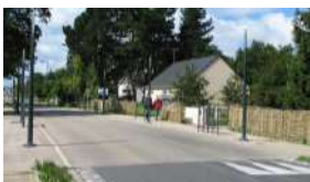
Exemple de requalification possible (CAUE 44)
