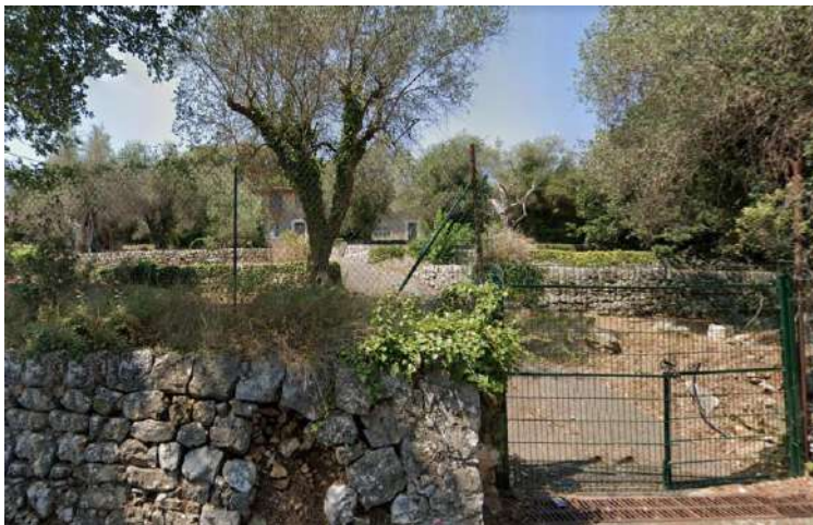
Remarquable mas agricole à Saint Julien bordé de restanques
