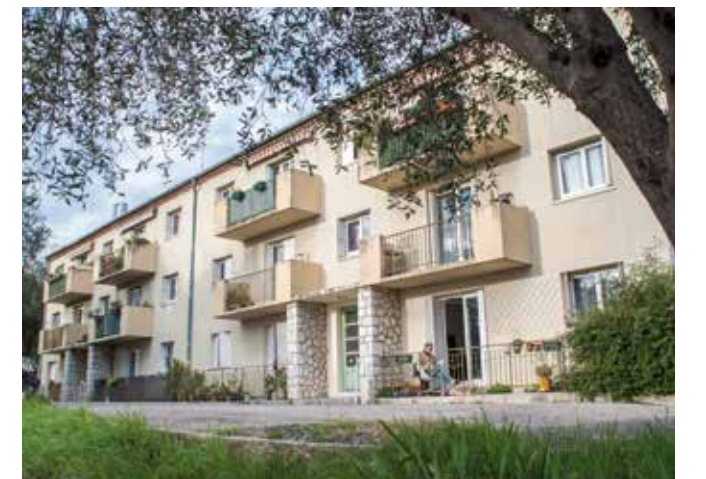
Logements sociaux "Les Oliviers" - route de Valbonne
