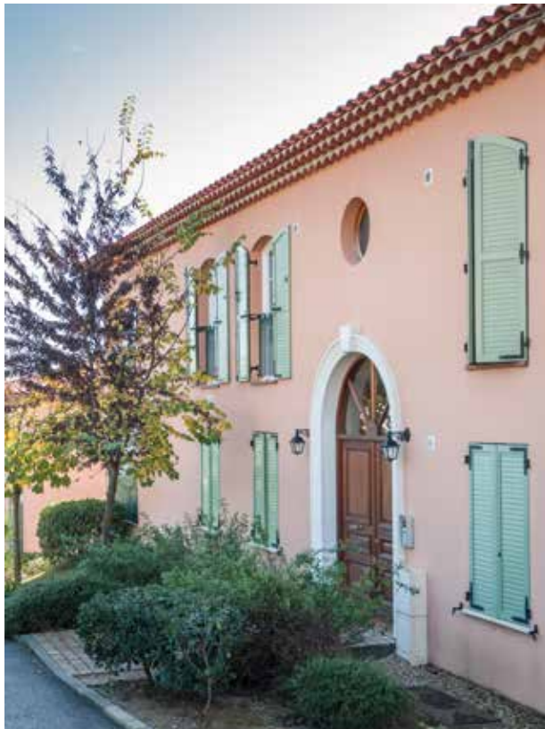
Logements sociaux "Les Florentines" - chemin des Cabots
