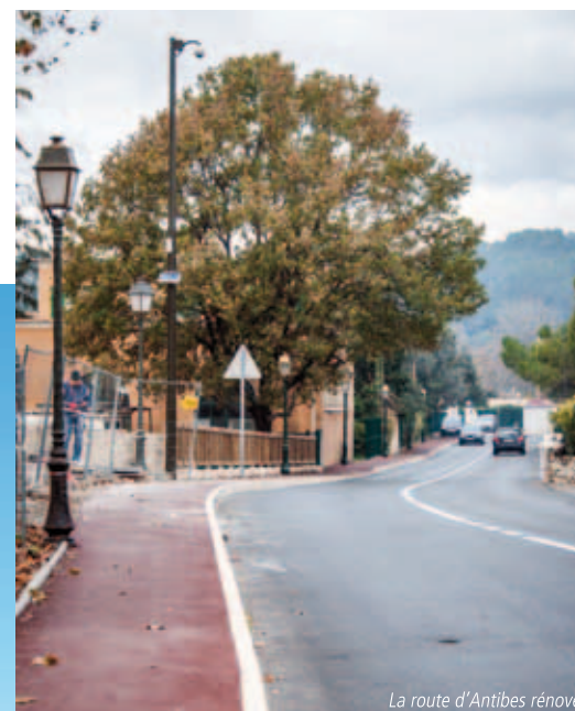
La route d'Antibes rénovée
