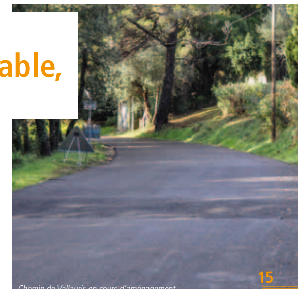
Chemin de Vallauris en cours d'aménagement
