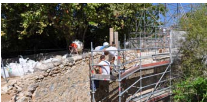
Le Pont Vieux en cours de restauration
